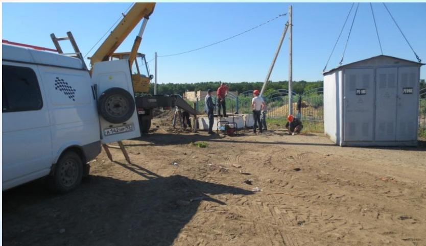
Для обеспечения временного электроснабжения строительной площадки и потребителя, смонтирована KTP.
